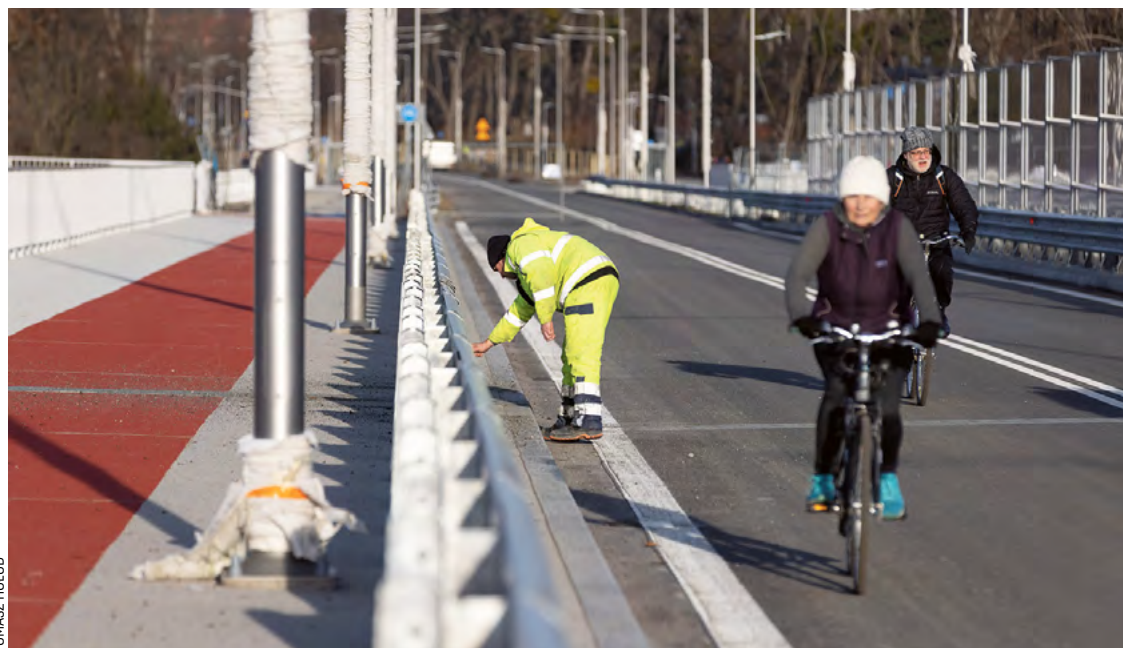
Aleja Wielkiej Wypsy to 3,5-km droga wraz z mostami nad Oławą i Odrą. Koszt jej budowy: ponad 250 mln zł
